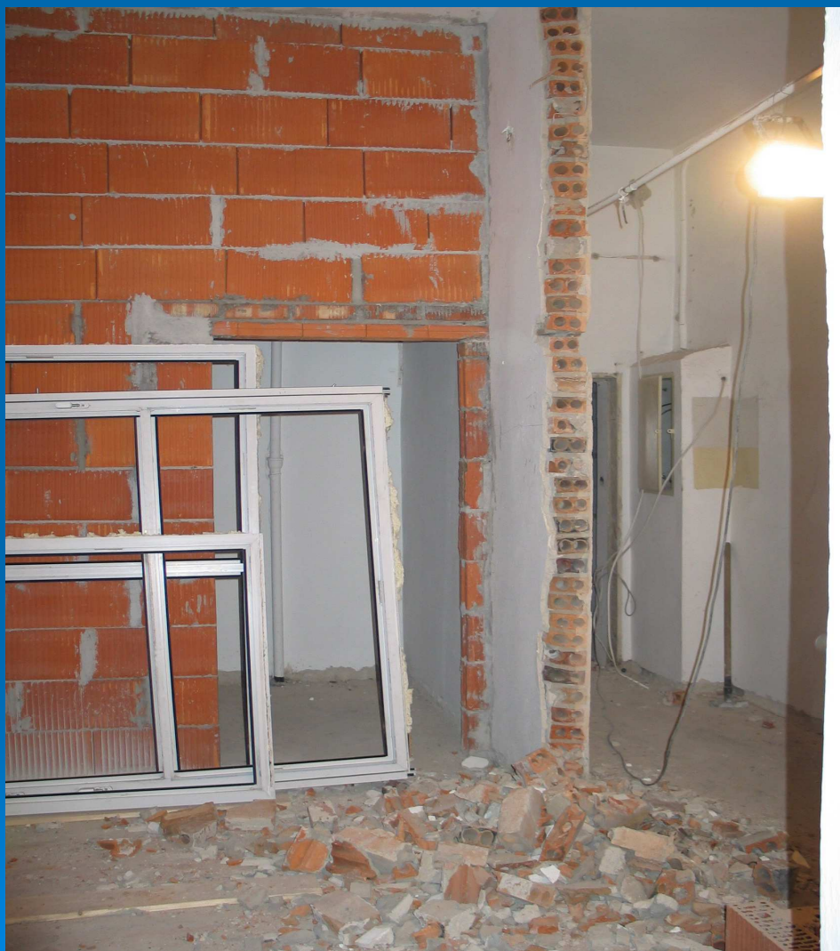
Cegła kratówka – brak pionowych spoin
