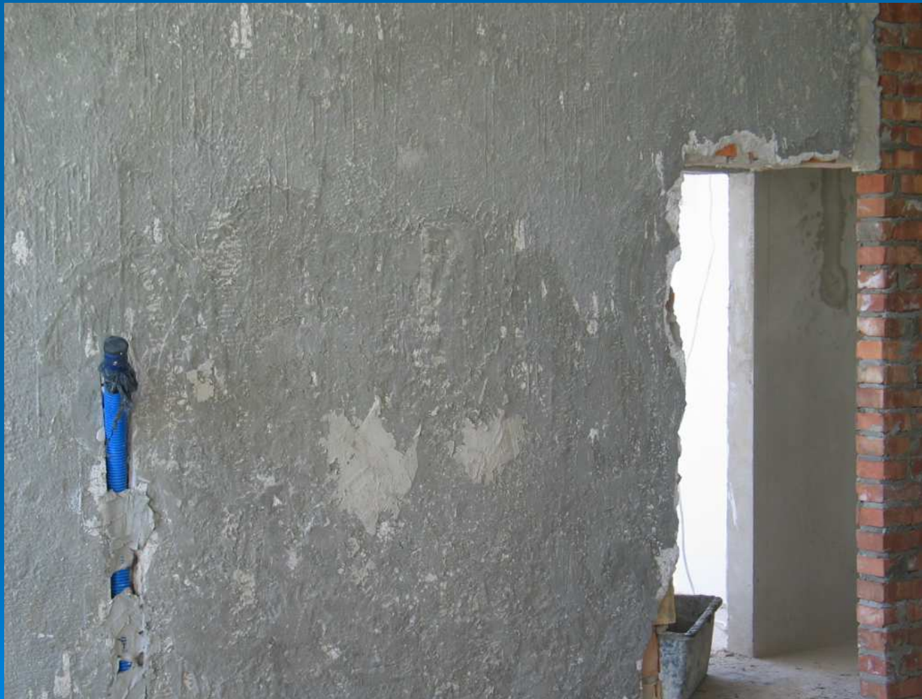
Rura 100-ka winidurowa w ścianie - uszczuplenie ochrony istniejącej substancji.
