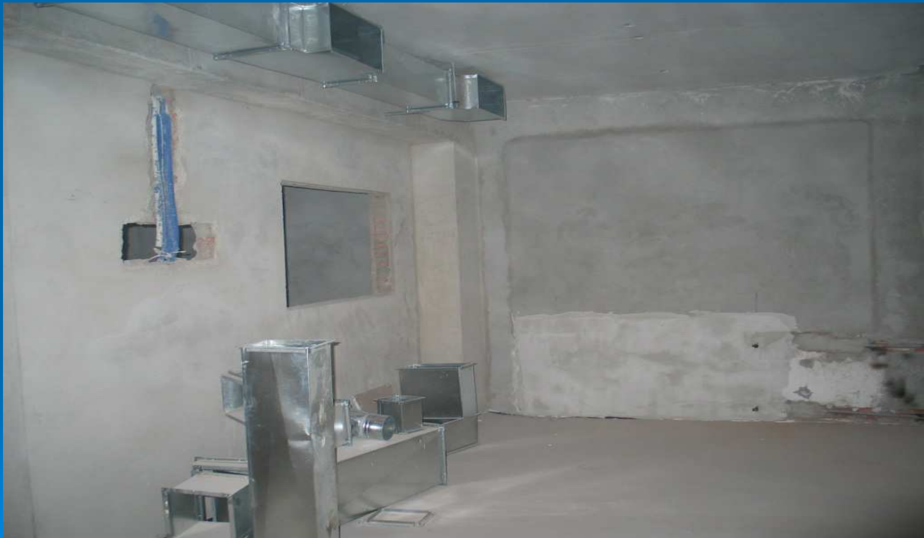
Rura 100-ka winidurowa w ścianie - uszczuplenie ochrony istniejącej substancji.
