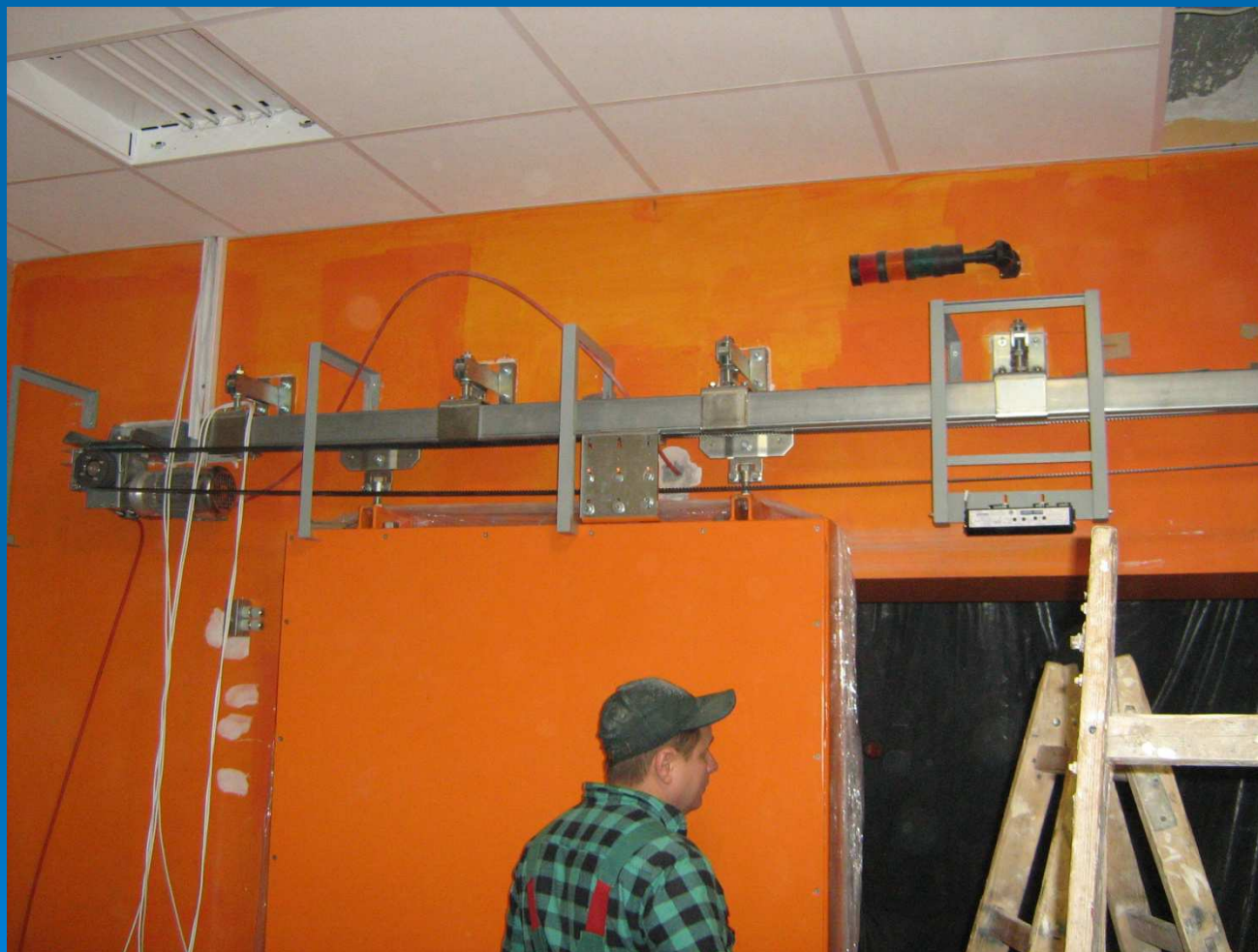
1. Radioterapia - Montaż drzwi przesuwnych z górnym zawieszeniem
