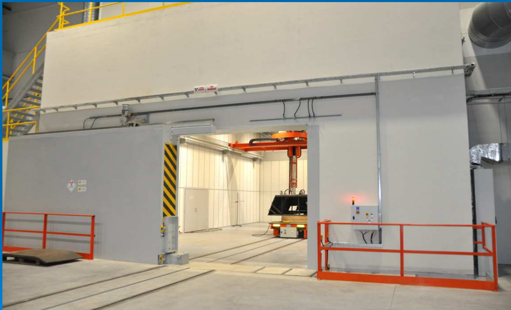
HSW SA Stalowa Wola - widok przy częściowo otwartej bramie wjazdowej do komory RTG
