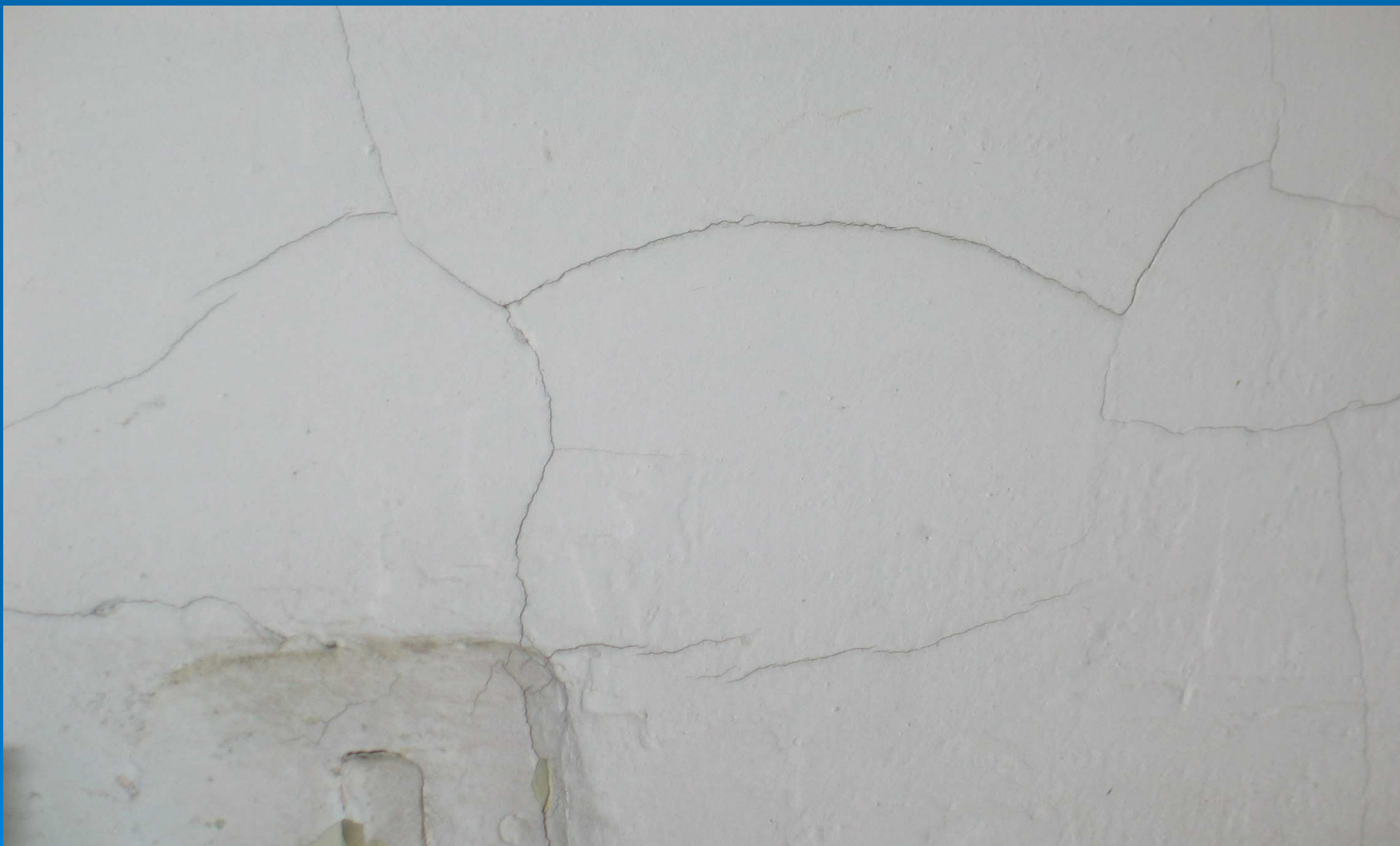
Spękany tynk barytobetonowy
