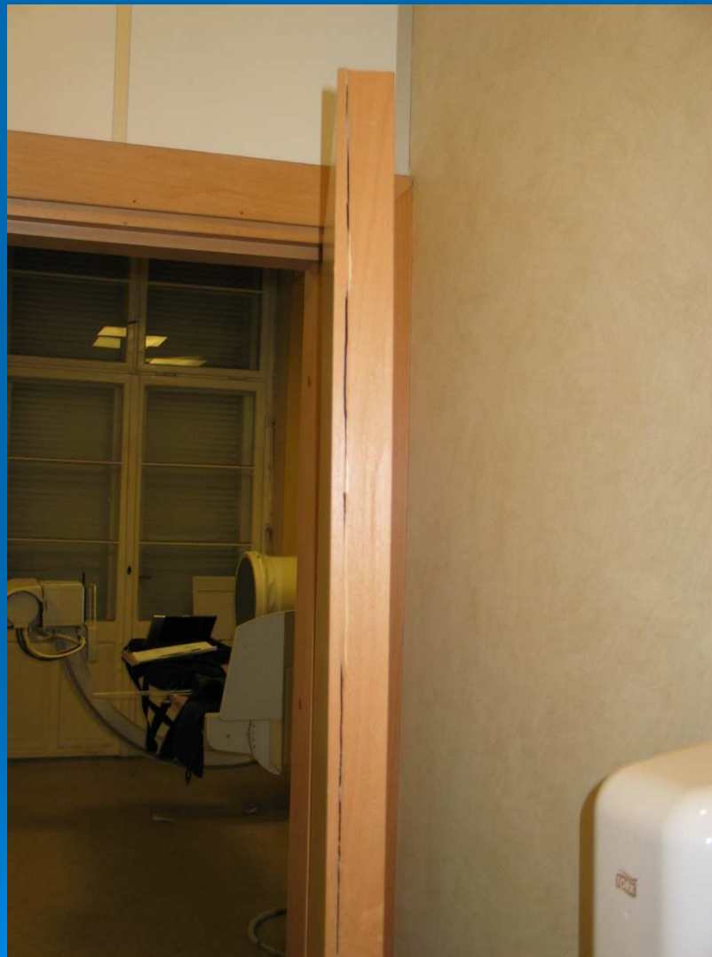
Podróby – skrzydło drzwi ochronnych, widoczne efekty rozwarstwienia spoiny drewno/Pb
