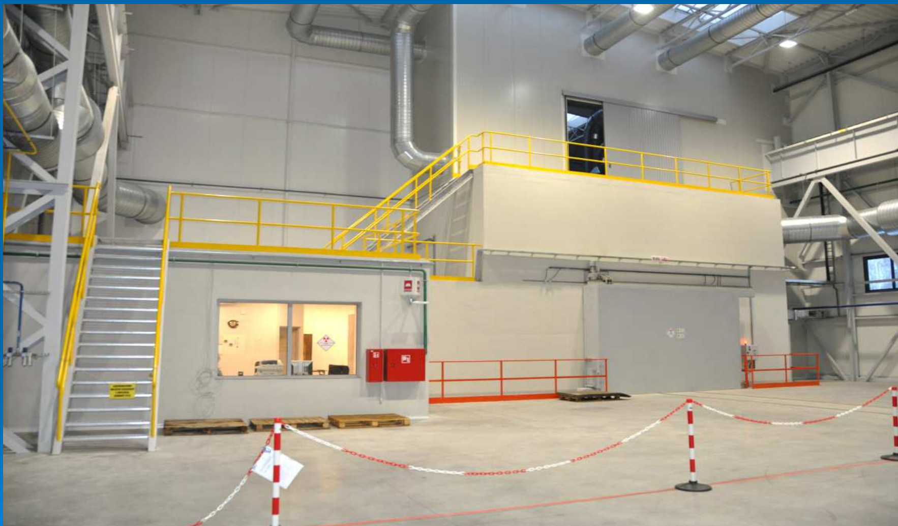
HSW SA Stalowa Wola - Komora RTG - widok od strony hali
