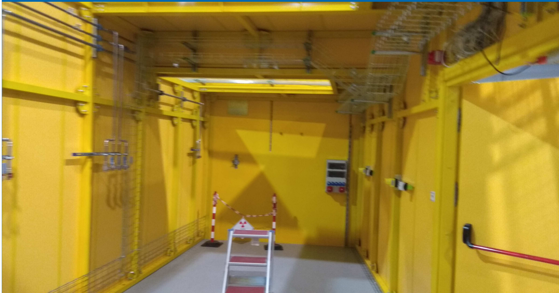
3. Linia badawcza – PHELIX, ściany w trakcie uzbrajania
